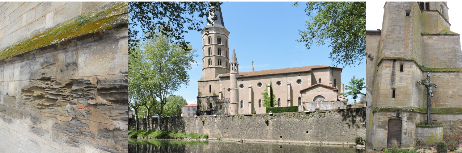
Credit photos © Fondation du Patrimoine
